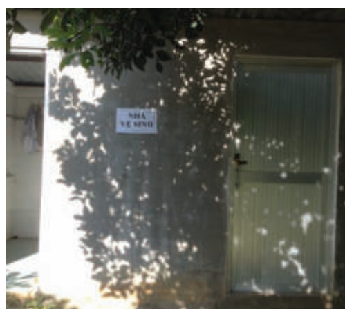
Hình 10. Nhà vệ sinh tự hoại
