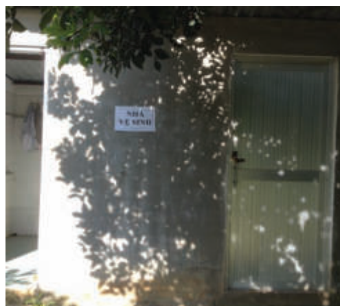
Hình 14. Nhà vệ sinh tự hoại
