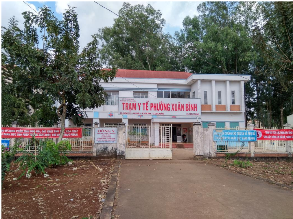
Trạm y tế phường Xuân Bình
