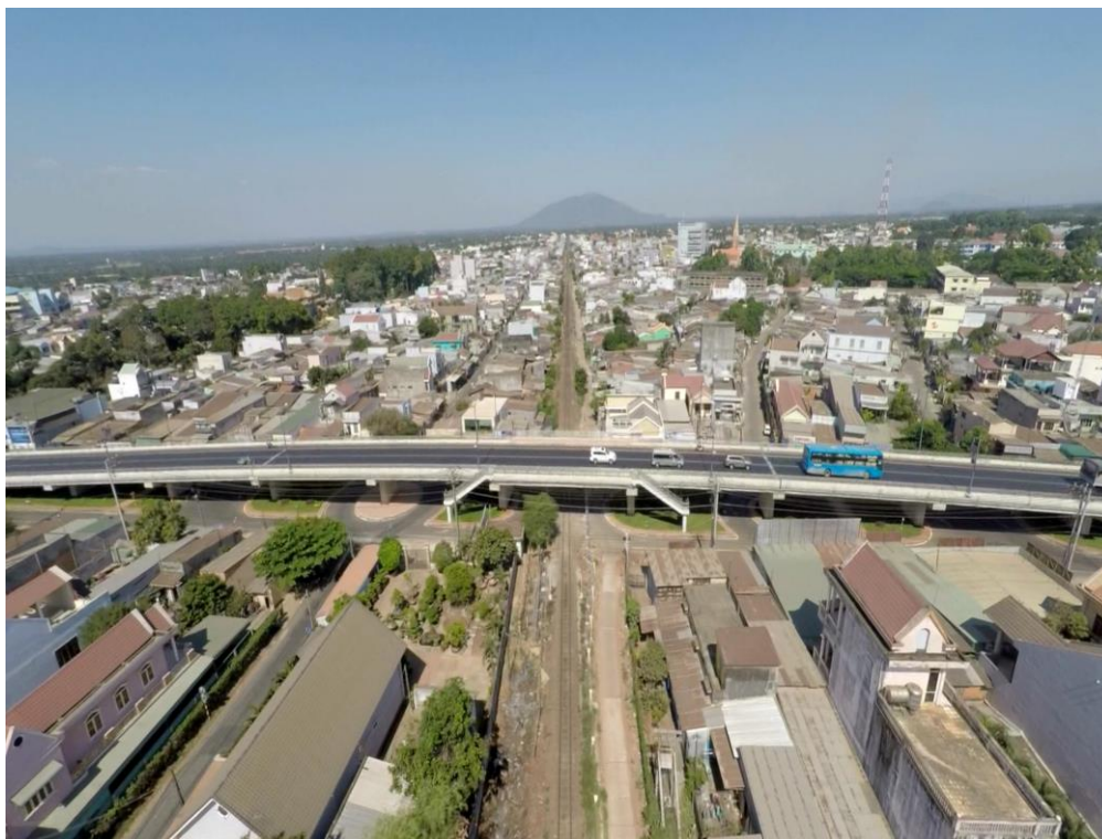
Cầu vượt Long Khánh (trên địa bàn phường Xuân Bình)
