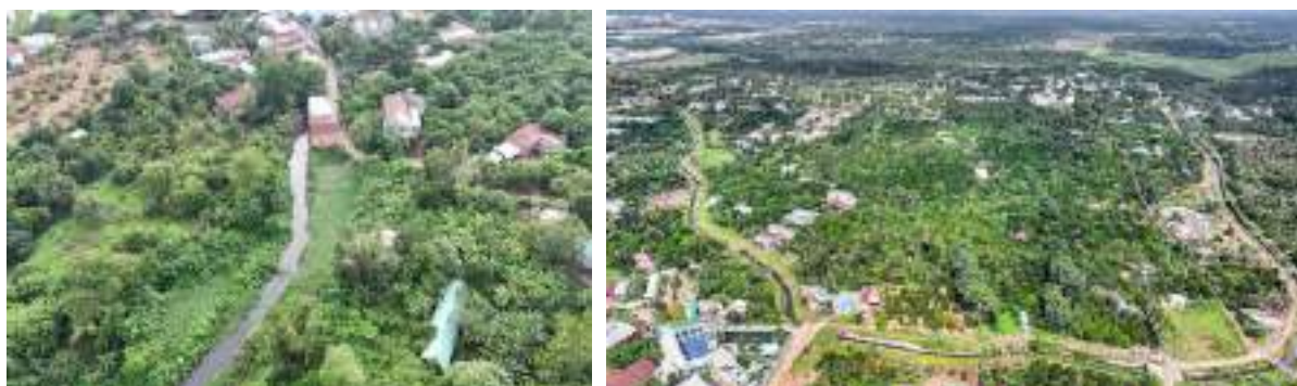
Hình 40: Tuyến mương thoát nước hiện trạng
