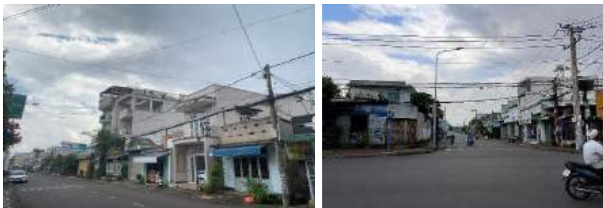
Hình 48: Hiện trạng tuyến cáp thông tin
