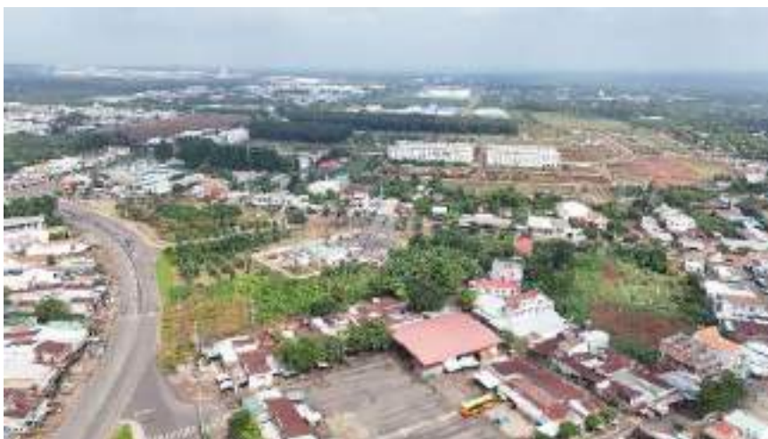
Hình 45: Hiện trạng 110kV Long Khánh và đường dây
