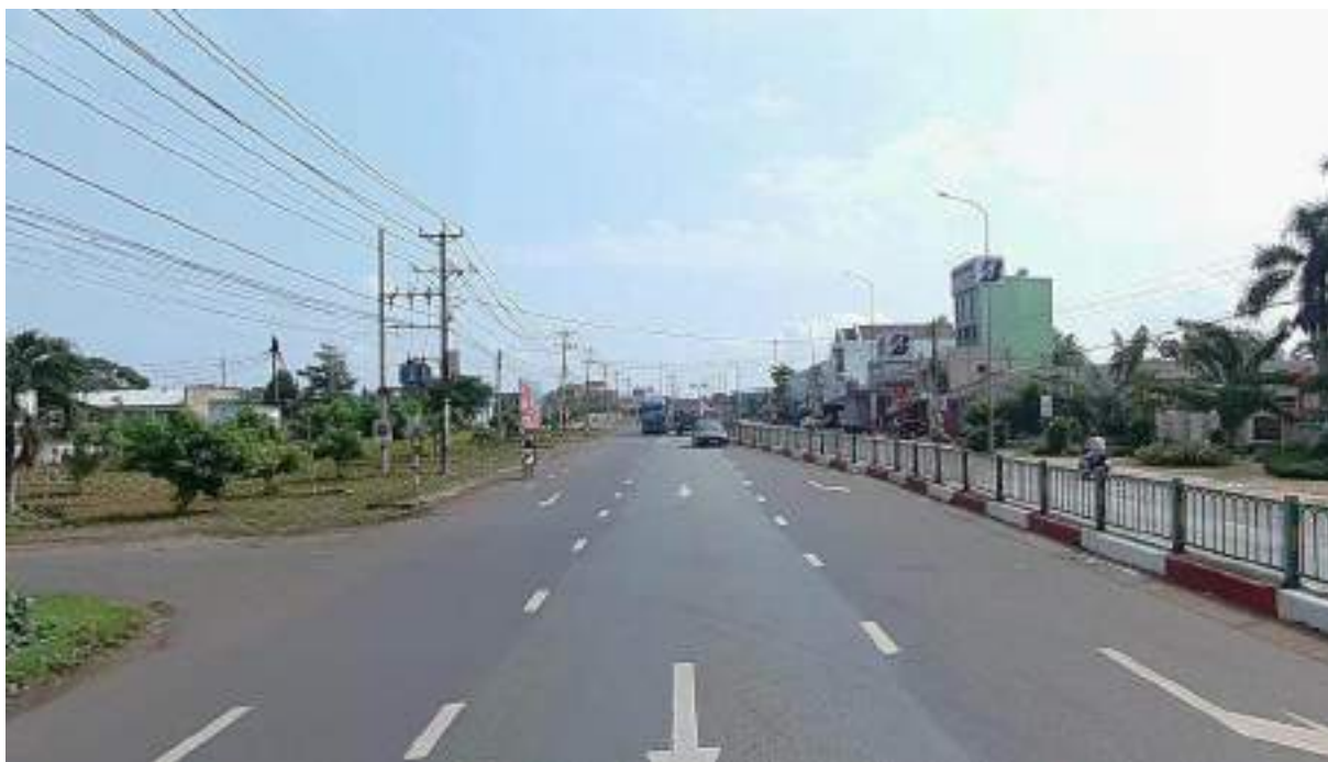
Hình 30: Hiện trạng tuyến Quốc lộ 1A đoạn đi qua thành phố Long Khánh
